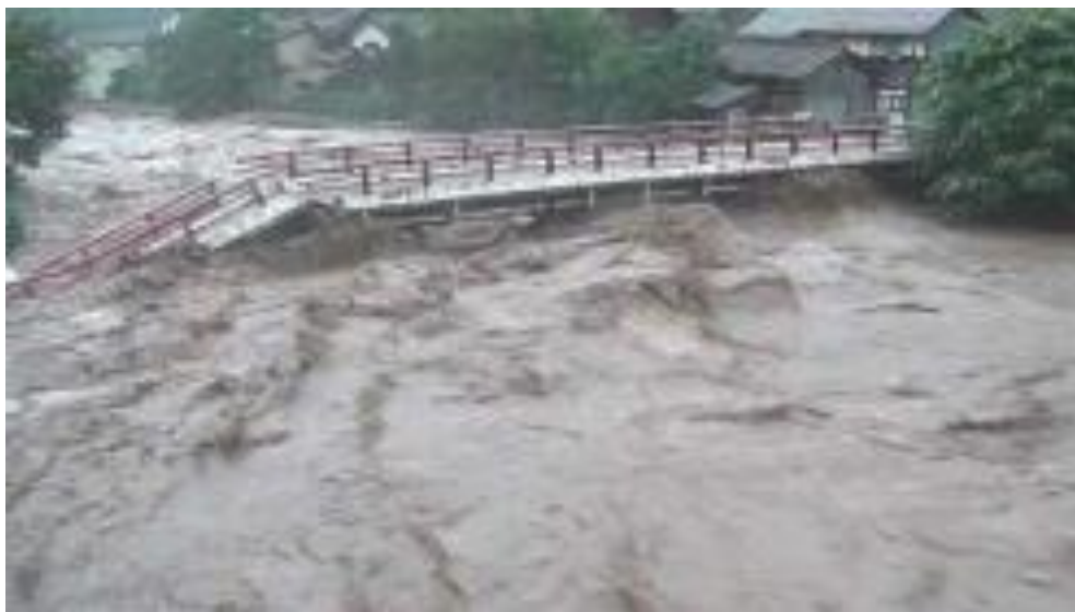
令和5年8月 台風7号 河川の増水による橋梁流失【鳥取県鳥取市佐治町】 出典：国土交通省
