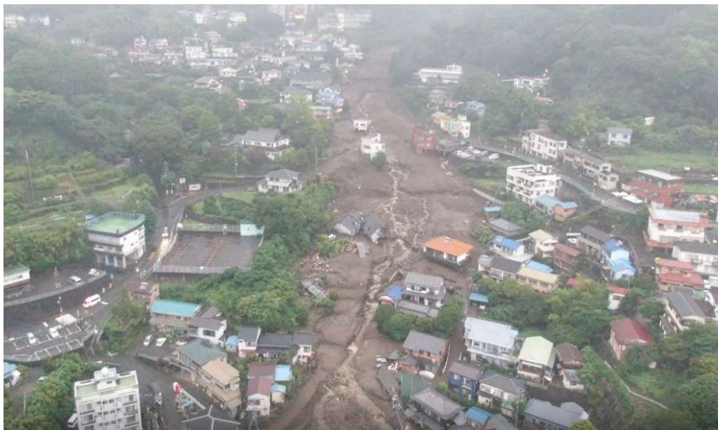
豪雨と盛り土に起因する熱海土砂災害 (2021年7月3日)【静岡県熱海市】 出典：国土交通省
