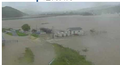
六角川（牛津川） 越流状況
