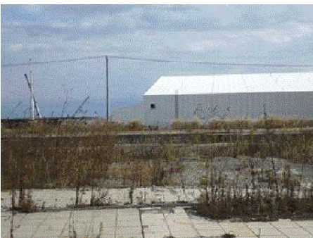
(駅舎が流された富岡駅)
